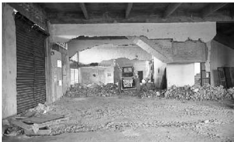
Máquina limpa o saguão de entrada do estádio.
