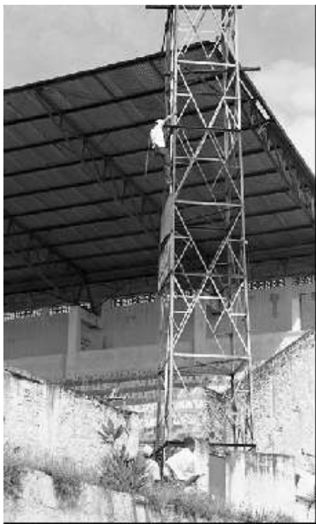
Homem preparando o desmonte de uma das torres.
