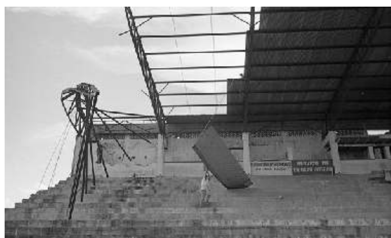
Retirada das telhas das cativas.
